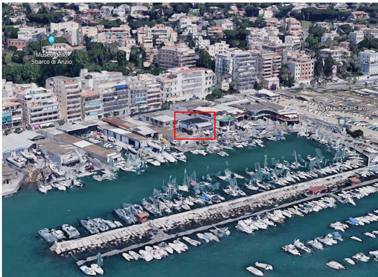
Figura 11 - Immobile di intervento
